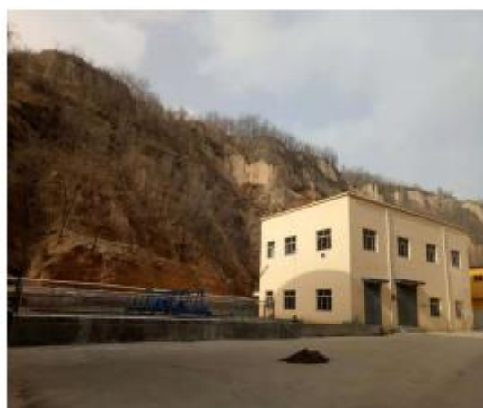
矿井水处理站
