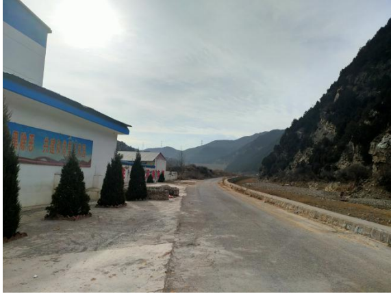
净水厂西侧场外道路
