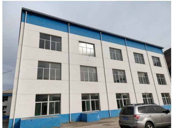
现有沉淀车间
