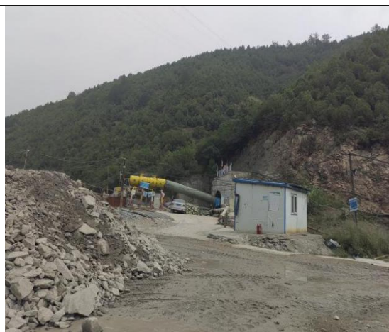
东线提水泵站位置
