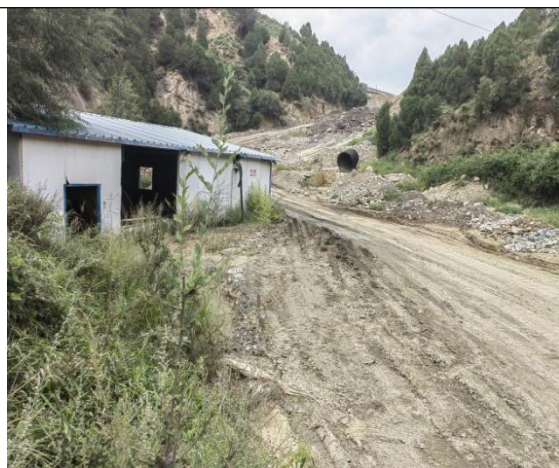
西线提水泵站场地
